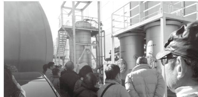
生ごみのリサイクルでできた都市ガスの貯蔵タンクを見学。
