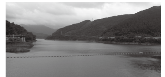
宮ヶ瀬ダムによりできたダム湖、宮ヶ瀬湖。景観が美しい。
