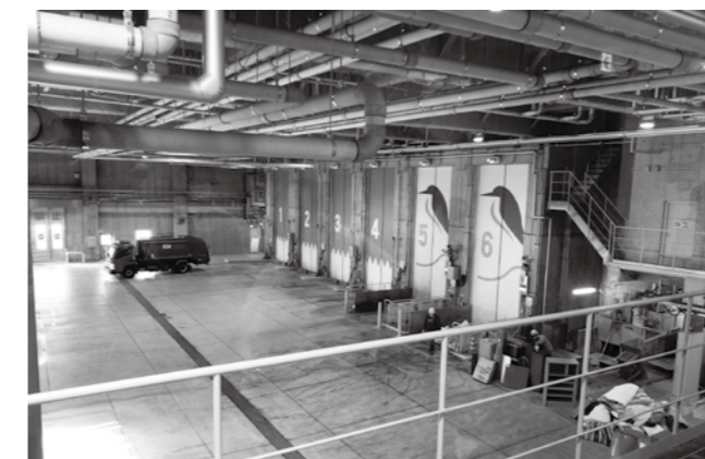
可燃ごみを搬入するプラットホーム
