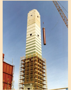
旧クリーンセンター建設中の煙突工事の様子
