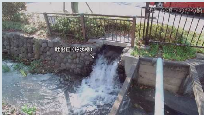
桜一の橋付近の吐出口
