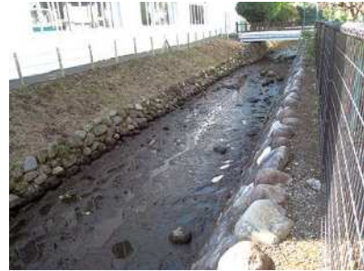
水が枯れた状態
