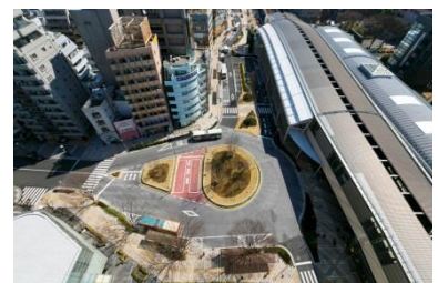
武蔵境駅北口駅前広場再整備
