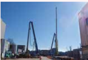
工事現場(令和6年2月13日撮影)
