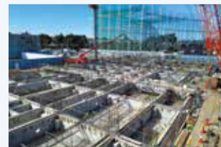
工事現場(令和6年2月27日撮影)
