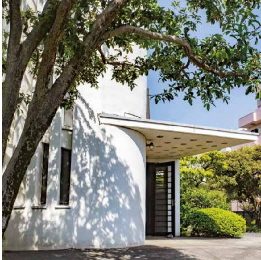
▲ 玄関・階段室外観
