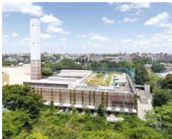
武蔵野クリーンセンター
