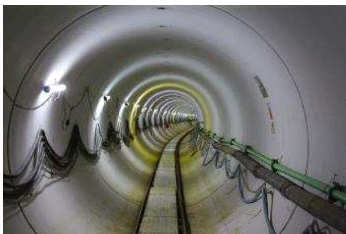
石神井川排水区雨水排水幹線
