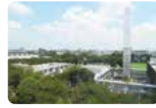
武蔵野クリーンセンター新管理棟・連絡通路
