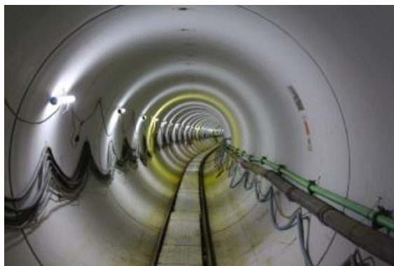
石神井川排水区雨水排水幹線
