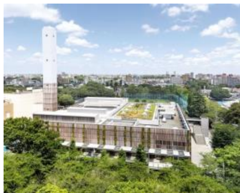
武蔵野クリーンセンター
