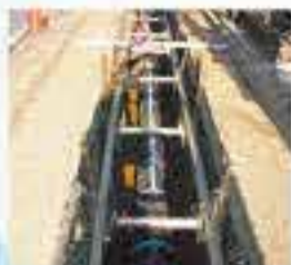
配水管更新工事の様子
