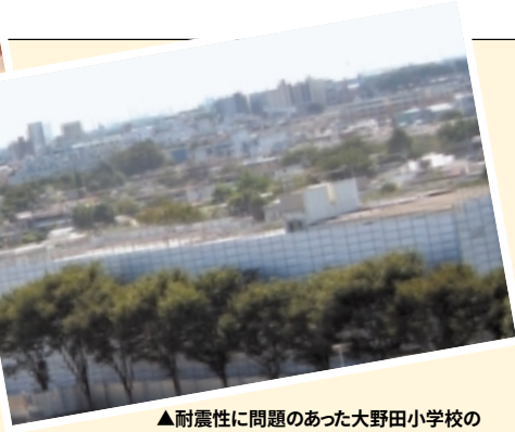
▲耐震性に問題のあった大野田小学校の建てかえが始まる
