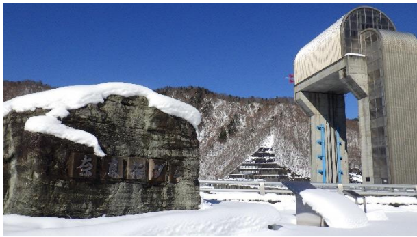
【奈良俣ダム見学】
