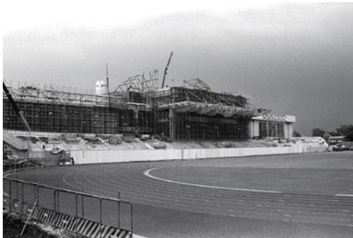
建設中の総合体育館
