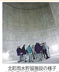
北町雨水貯留施設の様子（北町保育園地下、4500m 3 ）
