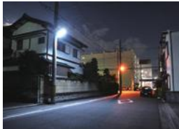
LED化された小型街路灯
