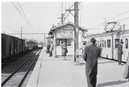
中央線下りホームを共用していた頃の武蔵境駅。是政方面を見る。(昭和40(1965)年2月25日撮影)
