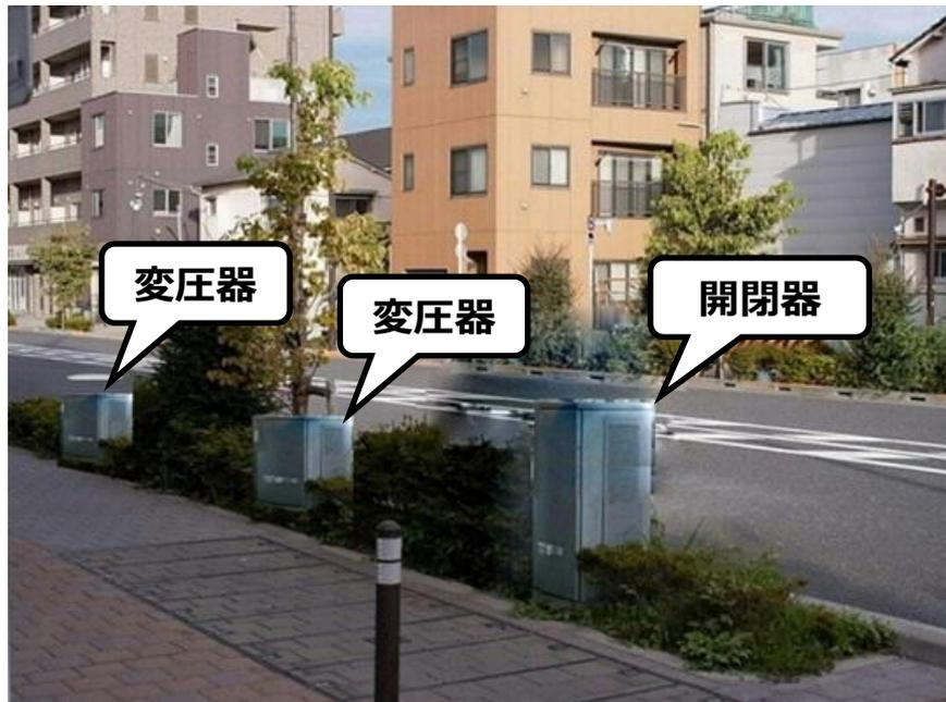
開閉器（スイッチ）と変圧器を分割した構造を検討
