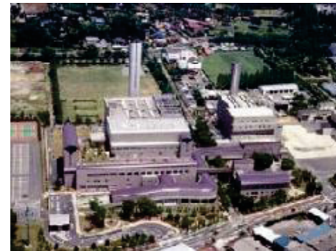
計画停電の際にも稼働し、発電 が行なっていた焼却場
