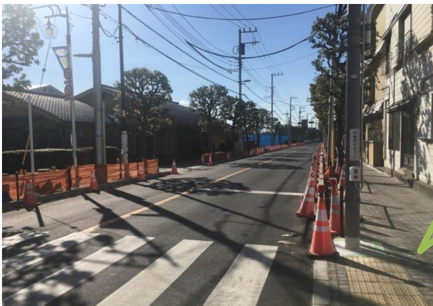
市道第80号線 電柱・電線あり
