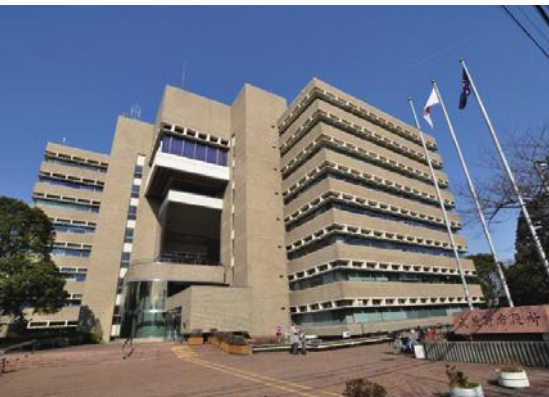
昭和55年に完成した現庁舎。
