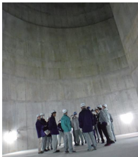
北町雨水貯留施設の様子 (北町保育園地下、4,500 m 3 )
