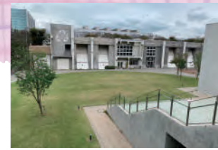
むさしのエコreゾート 外観
