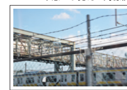
車窓から見える跨線橋
