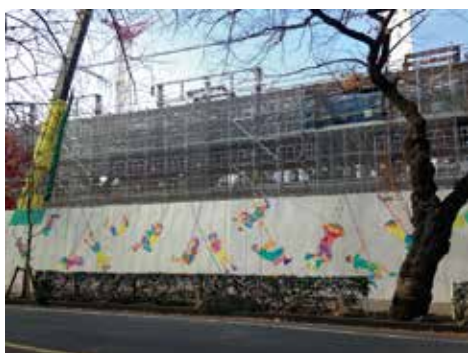
市内の小学生が参加して作成した 武蔵野クリーンセンター(工事中)の仮囲い
