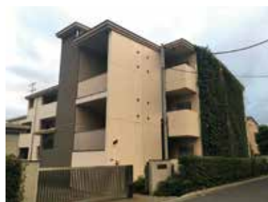
市営北町第1住宅
