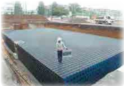
雨水貯留浸透施設
