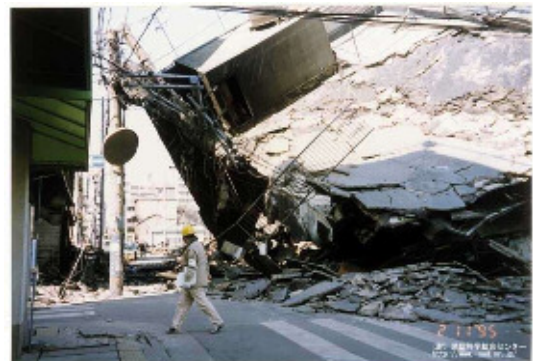
▲地震による被害の様子 (出典(財)消防科学総合センター)
