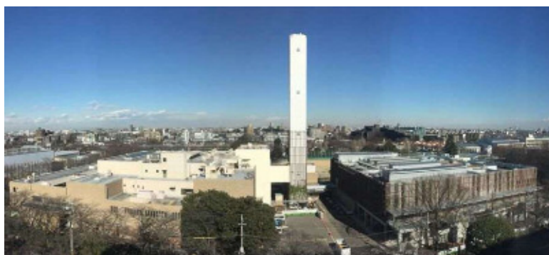
▲解体する旧施設(左側)と本格稼働する新施設(右側)
