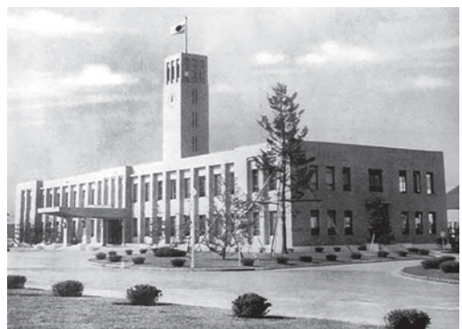
開設当時の中島飛行機武蔵製作所本館 （富士重工業株式会社蔵）
