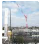
建設中の新武蔵野クリーンセンター(仮称)
