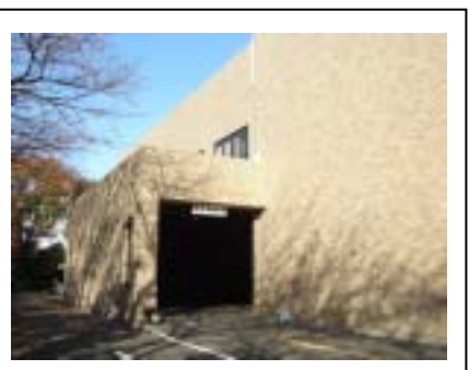
プラットホーム外観
