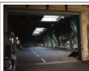
プラットホーム内部
