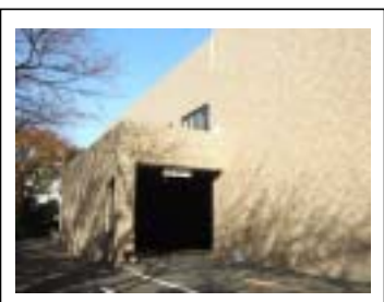
プラットホーム外観
