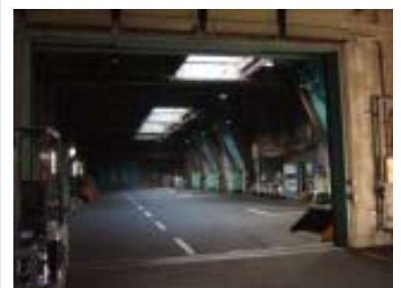
プラットホーム内部
