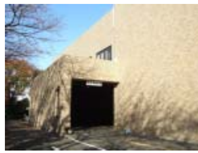
プラットホーム外観
