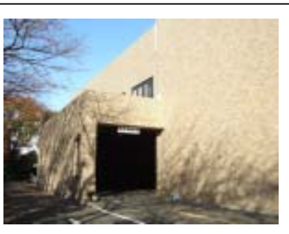
プラットホーム外観
