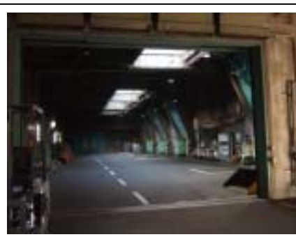
プラットホーム内部
