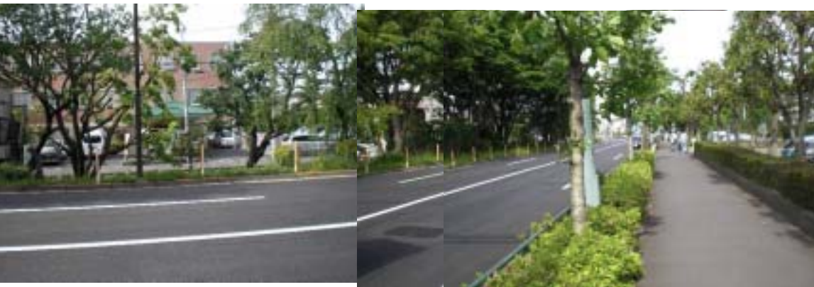
21. 富士重工工業社宅 出入口
