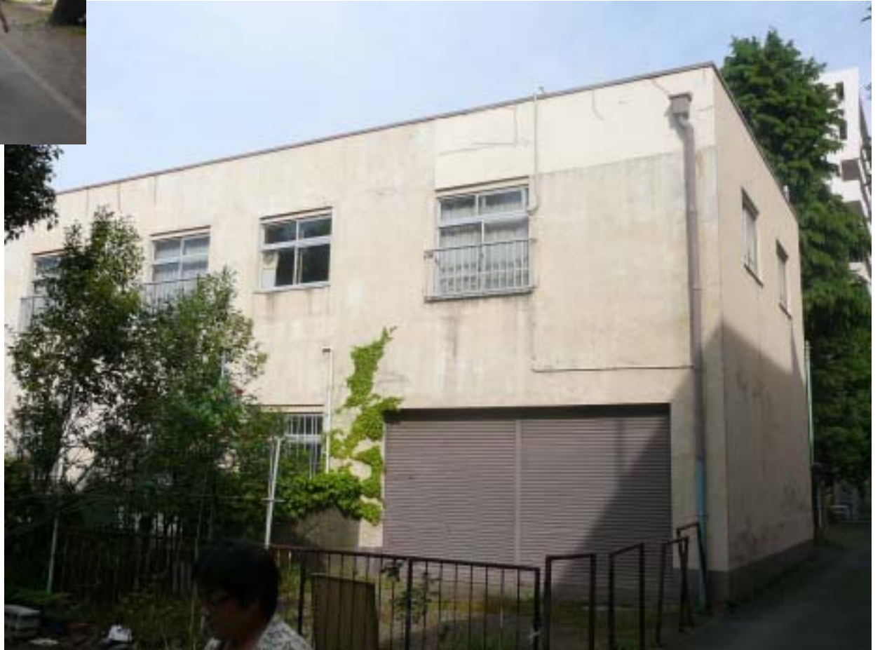
28. 中島飛行機製作所の変電所跡 【都営武蔵野アパート内】
