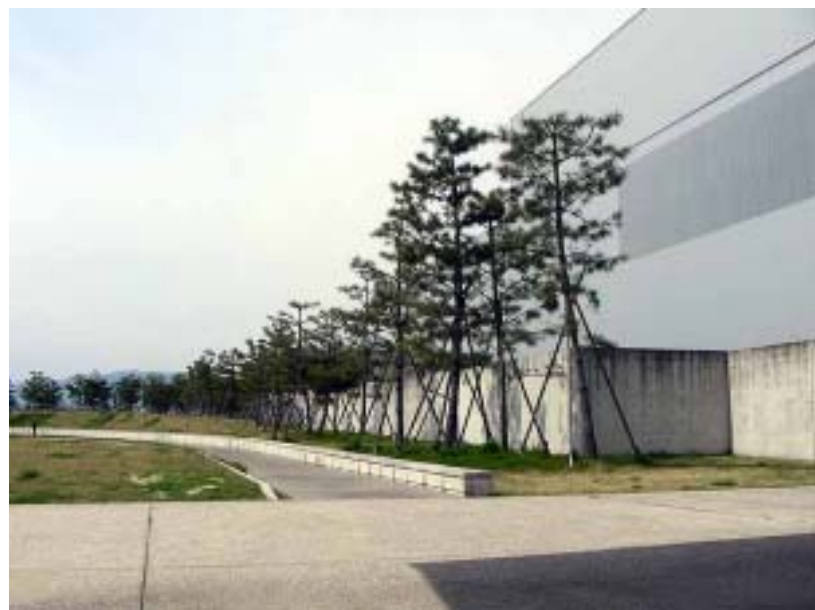
エコアシス 歩道
