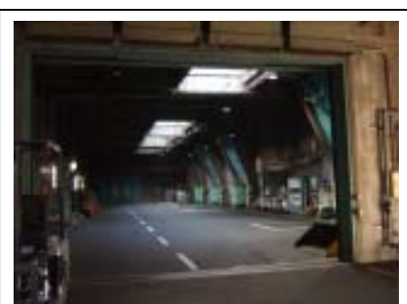
プラットホーム内部
