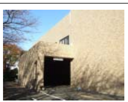
プラットホーム外観
