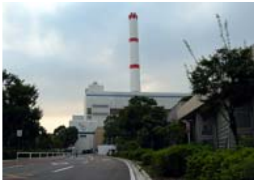
足立清掃工場
