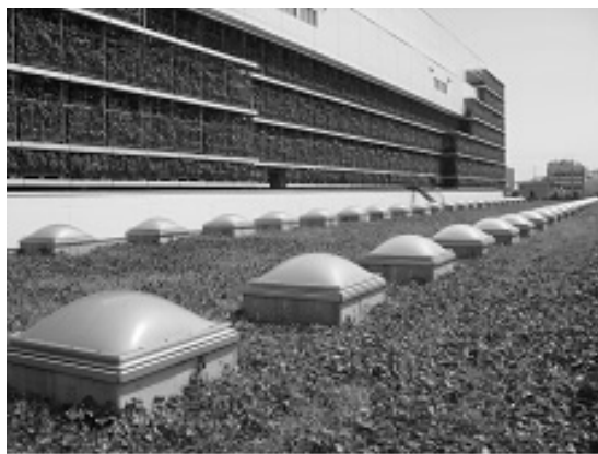
図 -23 壁面緑化例（板橋清掃工場）
