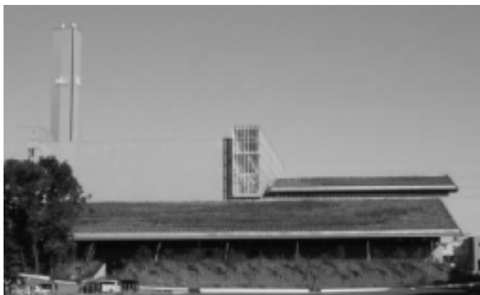
図 -22 屋上緑化例（所沢東部クリーンセンター）
