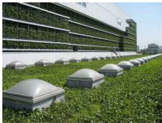
図 壁面緑化例（板橋清掃工場）
