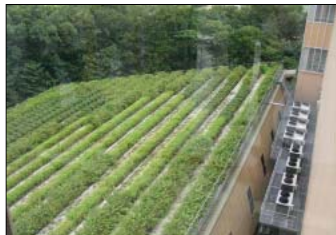
屋上緑化（プラットフォーム上部）と周辺の緑 8
