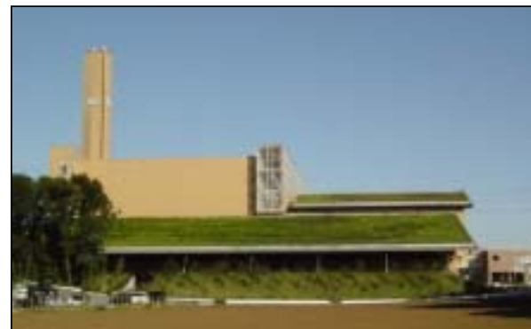
周囲の環境に配慮した屋上緑化
