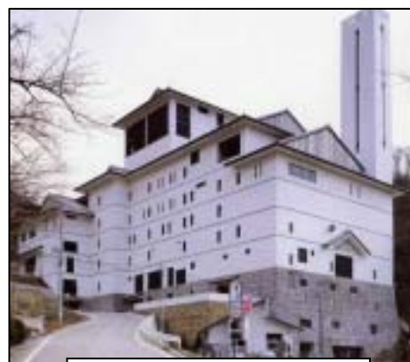
東山クリーンセンター全景
