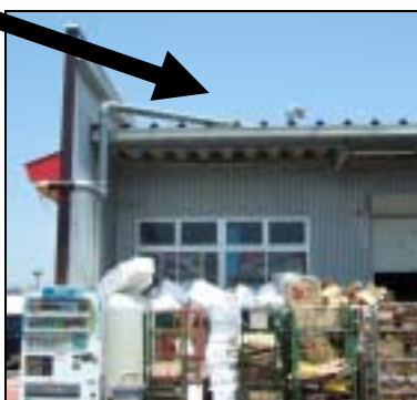
脱臭した後の空気を天井から排気
