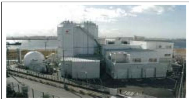
図は、東京都のスーパーエコタウン事業で整備された大田区城南島の施設です。事業系生ごみとして首都圏のホテル、スーパーマーケット、コンビニなどから排出される食品残渣や、食品加工工場等から排出される産業廃棄物の生ごみ（動植物性残渣）を処理しています。すなわち、食品リサイクル法の対象事業者がターゲットとなっています。図の一番左にある球体がメタンガスの貯留槽で、中心の円筒状の2本ある設備がメタン発酵槽です。ここでは、生成されたメタンガスを使い、ガスエンジンと燃料電池を用いた発電を行っています。電気の売却単価は高くないため、今後は都市ガスなどへのガス供給も検討されているようです。
