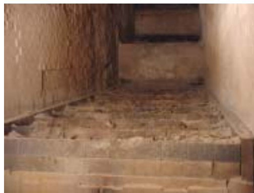
燃烧装置(炉内)
