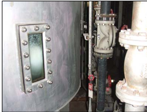
排ガスを薬品（苛性ソーダ）で洗浄し、塩化水素や硫黄酸化物を取り除きます。
