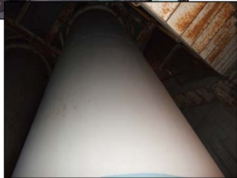
コンクリート製の外壁の中に鋼鉄製の煙突が3本入っています。
