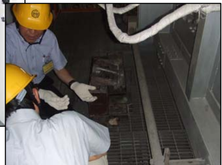
高温で消耗し、使 えなくなった焼却 炉内の火格子
