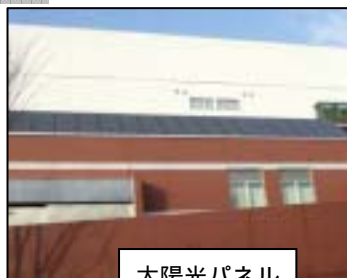
太陽光パネル
