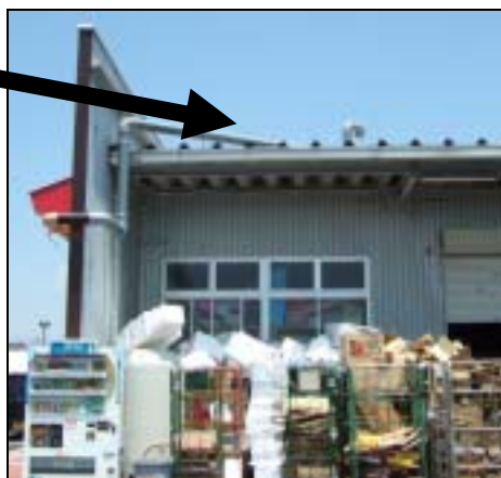
脱臭した後の空気を天井から排気
