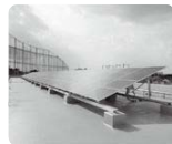
第五中 太陽光発電システム
